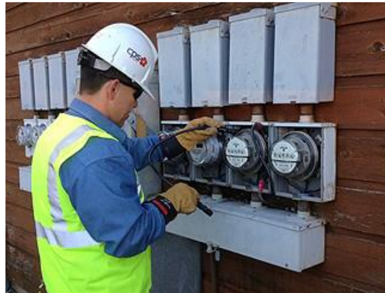
Verkeerde meterstanden veroorzaakt door 2kHz-150kHz emissies
