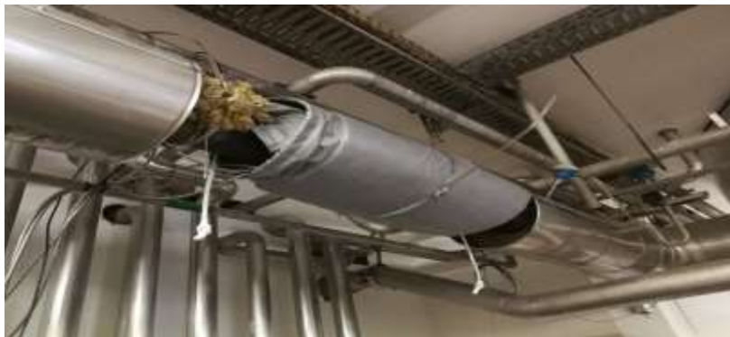
Leidingsysteem, samen met de transducers geheel ingepakt in isolatie om system (en transducers) op temperatuur te behouden
