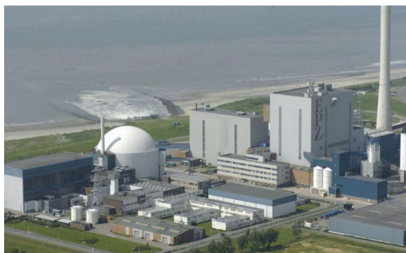
Energiecentrales (afbeelding Kerncentrale Borselle via ANP)
